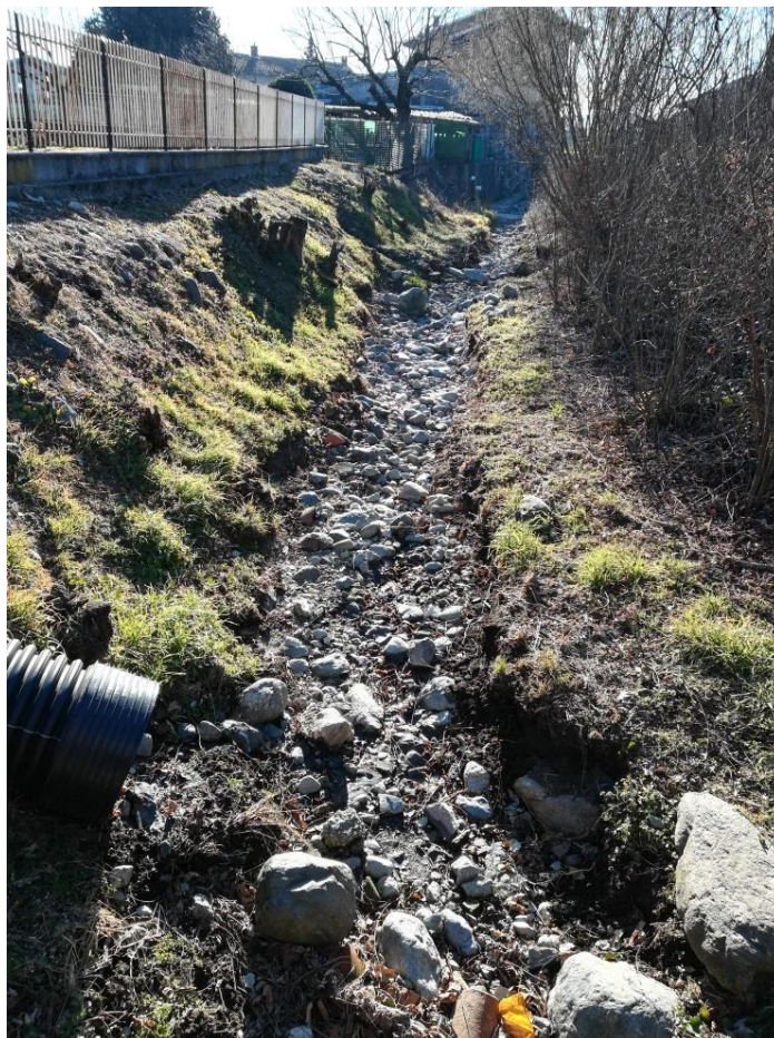
Figura 6: Sezione del Rio Morto nel tratto a monte dell'attraversamento di Via G.C. Rossetto con sponde erose dalla corrente.
