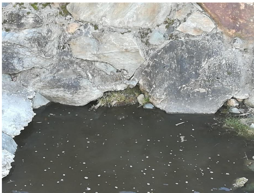
Figura 11: Particolare della fondazione mancante.
